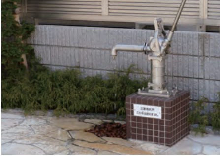
[東京都江戸川区 Aマンション] 住民の安全と防災用水対策として。
