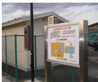
機材倉庫外観
