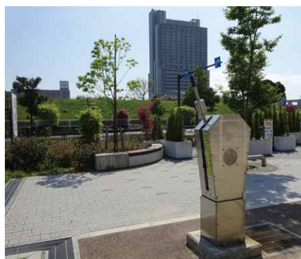
〔東京都 石浜城址公園〕 地域住民の防災用水対策として。
