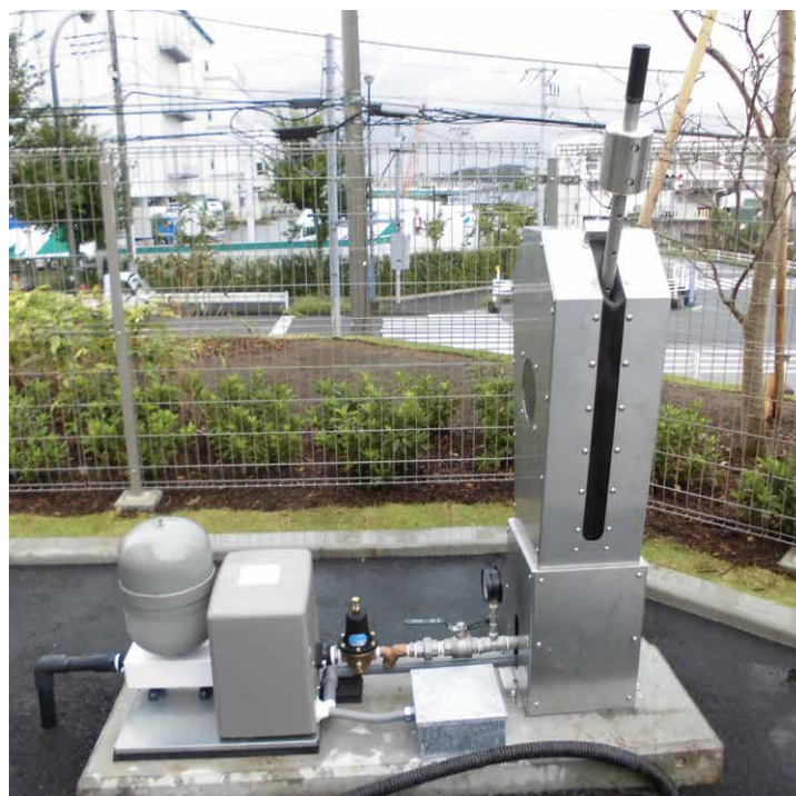
※写真は据付参考写真です。
