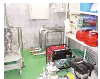
倉庫内配備状況
