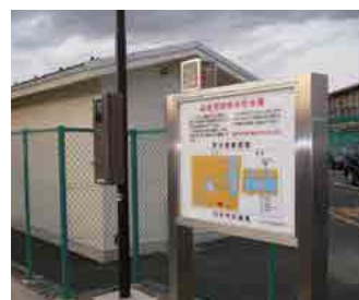
機材倉庫外観
