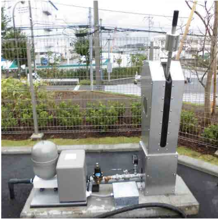
※写真は据付参考写真です。
