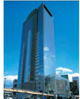
AERビル2F・5F・6F
