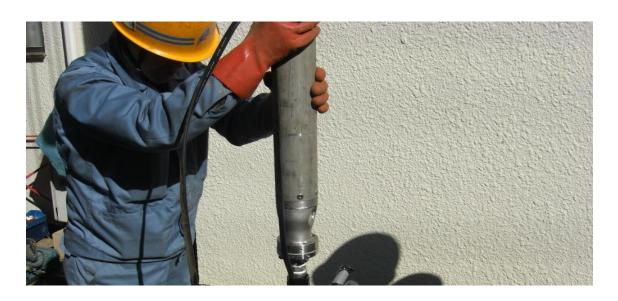
先般、千葉県松戸市内にある K 様邸にタンデム式手押しポンプを設置しました。こちらの井戸は K 様が所有されていますが、有事の際は町内会の皆様が使用される防災井戸として活用されるとの事です。当初はガスボンベにて運転可能な発電機を町内会で購入され、設置する予定でした。しかし、ガスボンベの場合、使用期限や保管上の問題が出てきます。その為、通常時は動力ポンプにて揚水し、有事の際にはバルブを切り替えるだけで手押しポンプにて揚水できる弊社のタンデム式手押しポンプをお勧めしたところ、大変興味を持って頂き、設置をさせていただきました。
