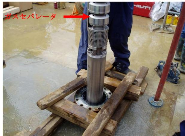
源泉ポンプを据付、最後に温泉付随ガスを除去の為にインラインガスセパレータを据付、作業完了となりました。ガスセパレータ流入前はガス濃度が濃すぎて測定不能でしたが、ガスセパレータ通過後の測定値は 1.5%LEL と基準値以下の値でした。(法令基準値は 5%LEL 以内)
