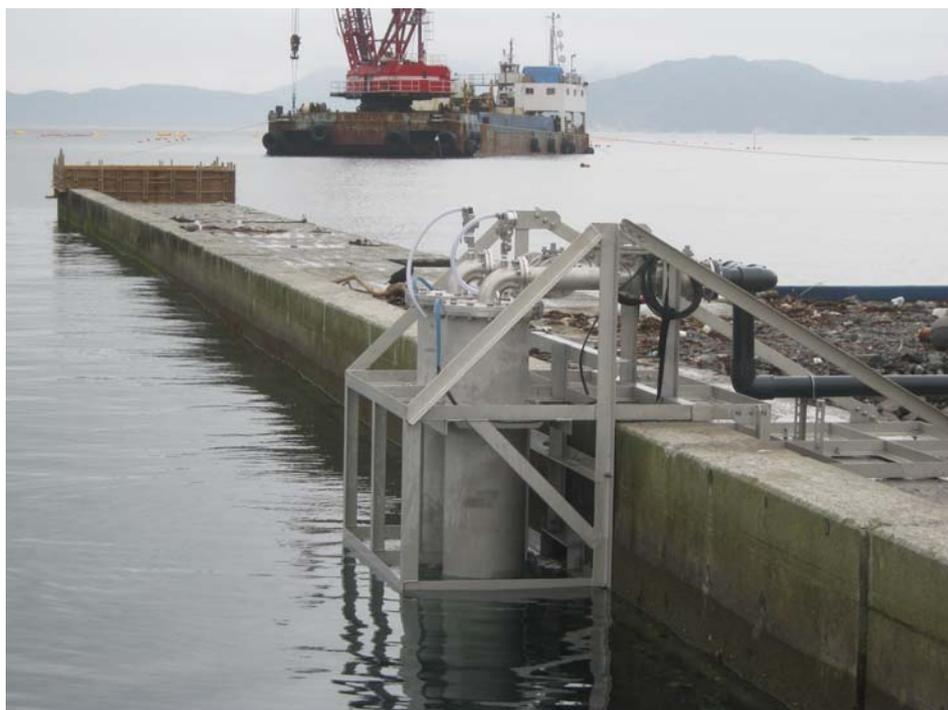
ポンプ本体に電気防食のためのアノードを取り付けた海水専用のポンプを選定。システムの材質は「SUS316LとAISI904L」の組合せで耐腐食性に優れています。
