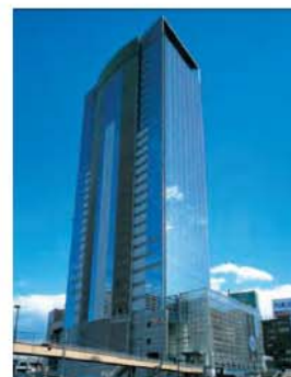
AERビル5F・6F・21F
