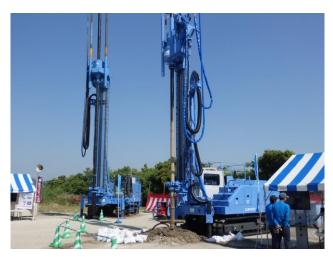
YBM 様の技術の一例を紹介しますと、冒頭に述べさせて頂きました「全自動施工管理システム」とは従来は計測室オペレータの技量に左右されていたものを施工機、圧送ポンプ、プラント間のデータのやり取りを無線化し、コンピュータが正確に制御するため、安定した工事品質が確保でき、施工環境の変化や施工機の移動に付随した作業が軽減される画期的な施工管理システムです。
