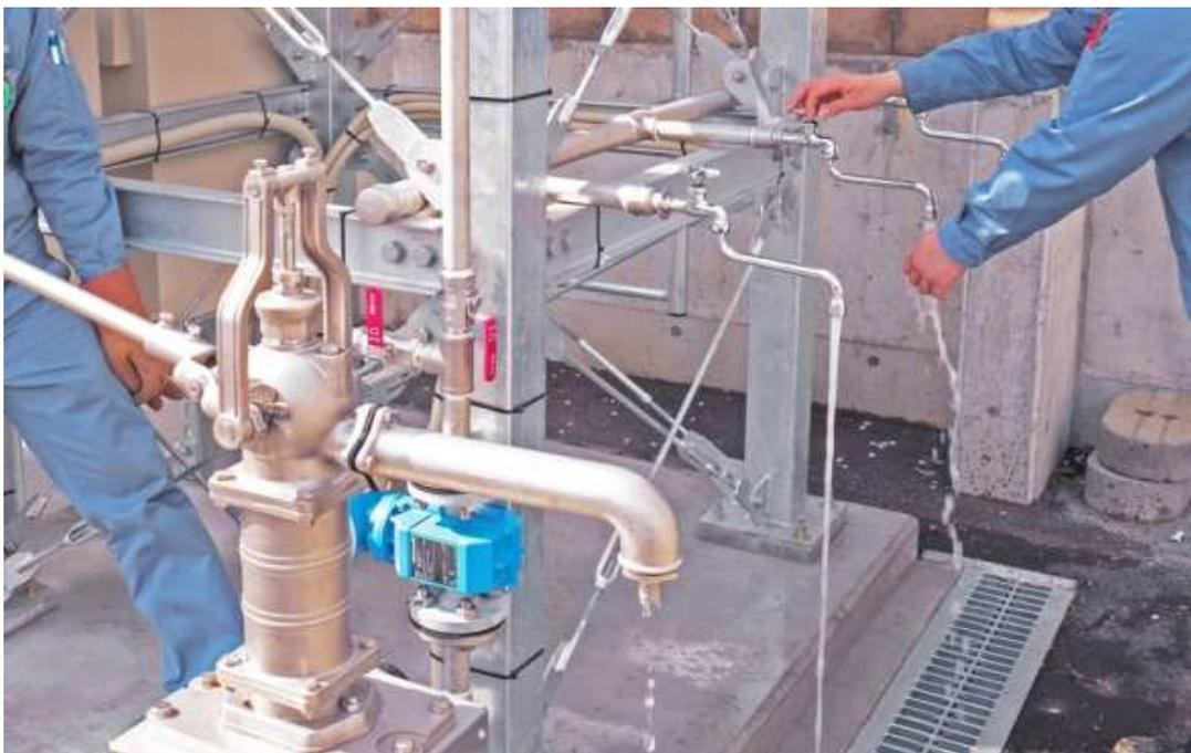
井戸の掘削、水中ポンプ／高架水槽／太陽電池パネルの設置を行い、一つのシステムとして制御を行います。
